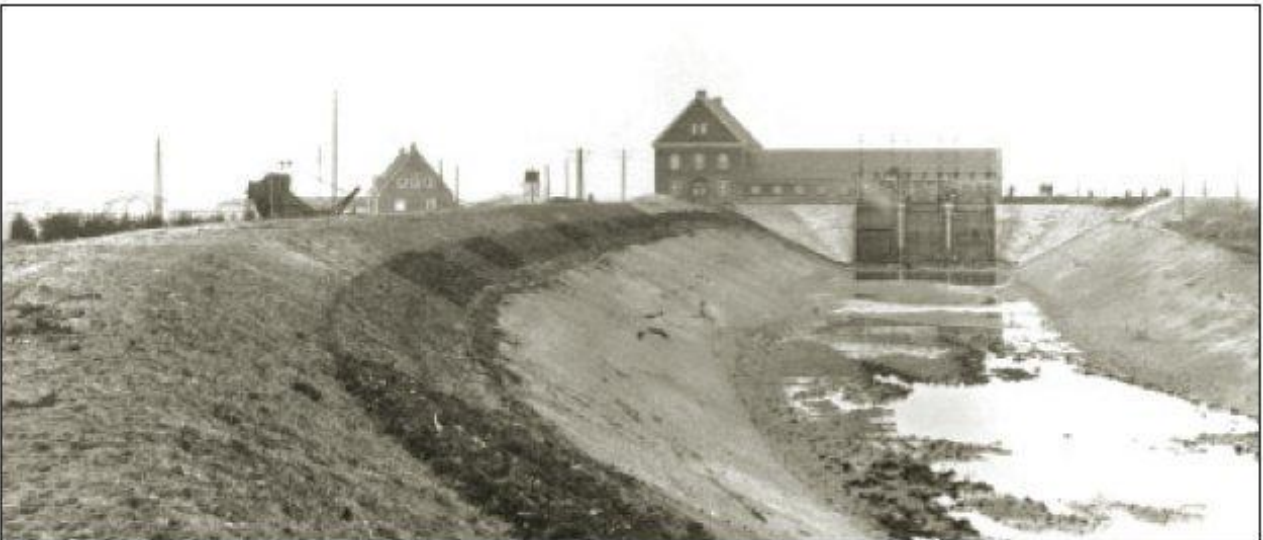
Figur 2. Fra opførelsen af Tangeværket, 1920
